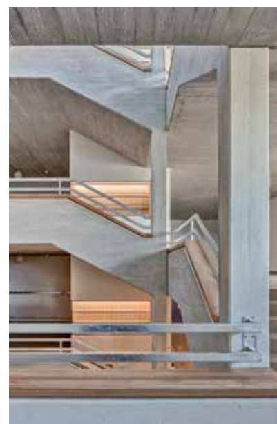
Die Eingriffe im Altbau, wie die Erhöhung der Brüstungen , sind zurückhaltend ausgeführt.
