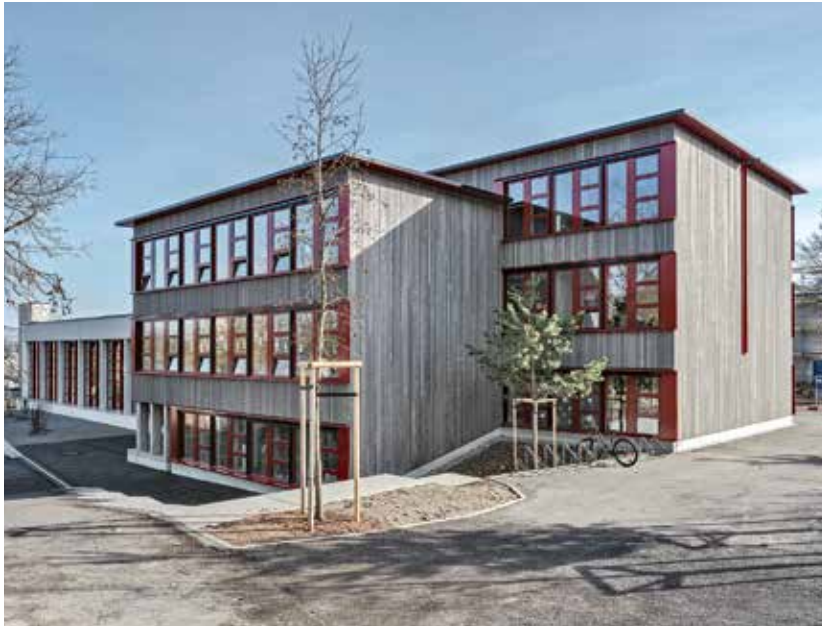
Der Neubau ist eine Holzkonstruktion – auch weil er auf einer ehemaligen Luftschutzanlage steht.
