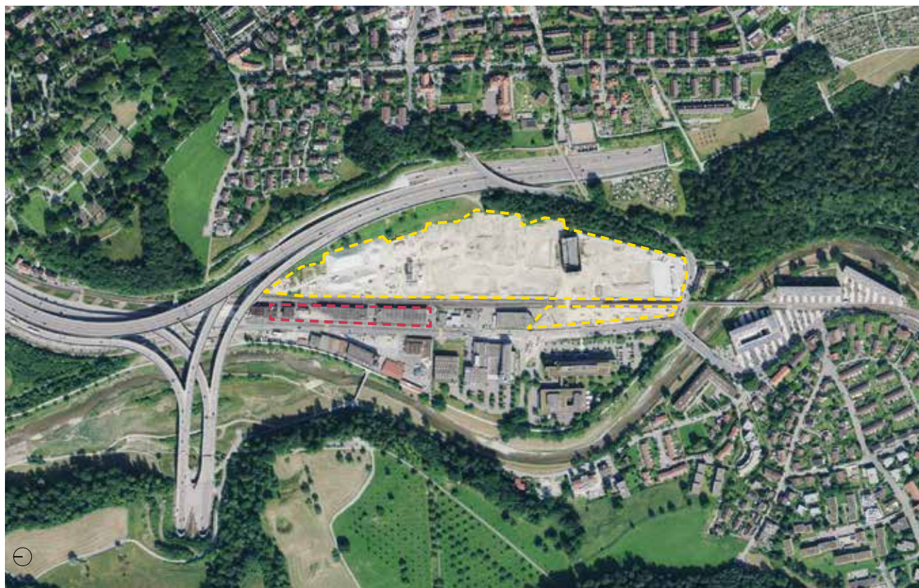
Luftbild des Entwicklungsgebiets Manegg aus dem Jahr 2015. Gelb der Perimeter, auf dem seither entlang der Allmendstrasse kammartige Neubauten und zwischen dem Bahntrasse und der Autobahn das 2000-Watt-Areal «Greenicity» entstanden. In Rot der Wettbewerbsperimeter für den Neubau der Schulanlage Höckler.
