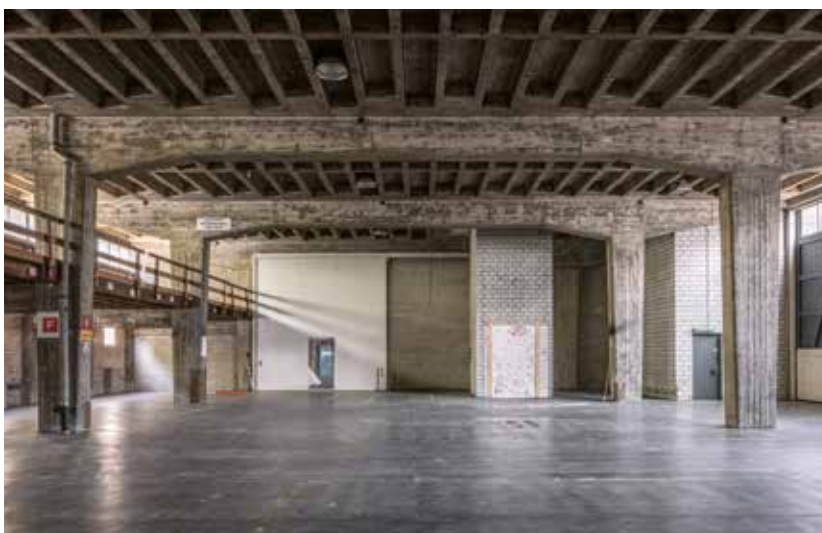
Eine der bestehenden Gewerbehallen der ehemaligen Firma Locher & Cie. Die Tragstruktur wäre robust genug, um in den Neubau der Schule integriert zu werden.
