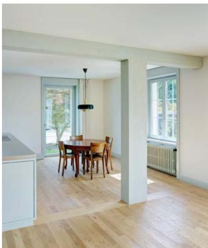
Ein neuer Unterzug und eine neue Stütze ermöglichen einen **durchgehenden Wohn-/Essbereich**.
