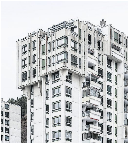
Detailaufnahme der Fassaden.
